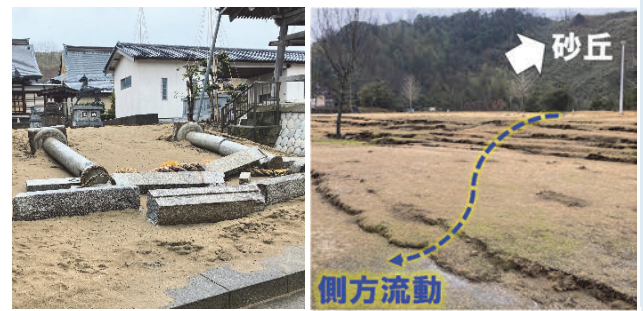
倒壊し、噴砂に覆われた鳥居
